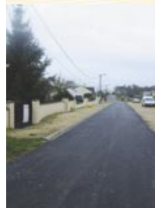
Eix, rue du Chauffour
